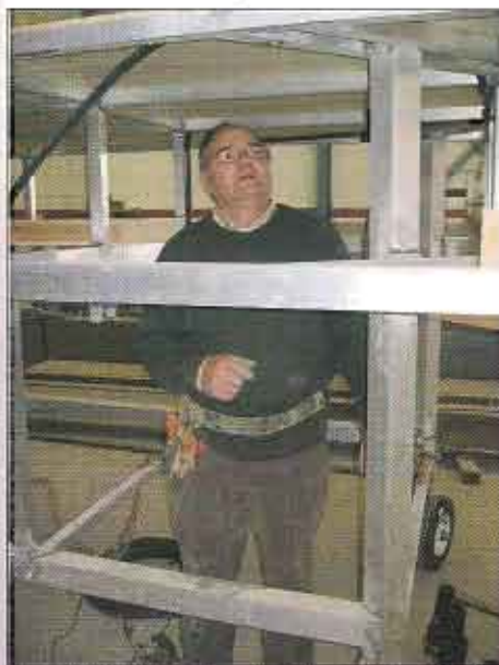
Juan "El Manta" realizando la instalación eléctrica del trono
